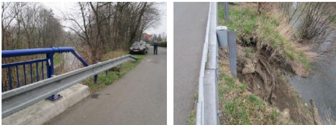
Foto 1 – Úsek 1, zátrh ve svahu v koncové části OZ, s propagací do koruny svahu a N.K. vozovky
